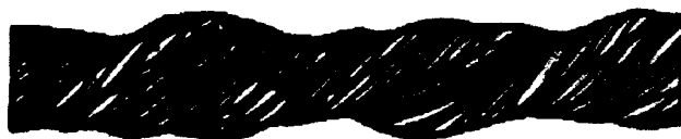
Рис. 6. Местное уменьшение диаметра каната на месте разрушения органического сердечника.
